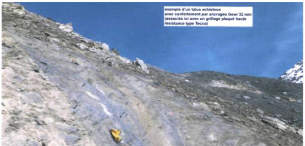
Exemple de talus schisteux avec confortement par ancrage Gewi 32 mm, associé ici avec un grillage plaqué haute résistance type Tecco.
